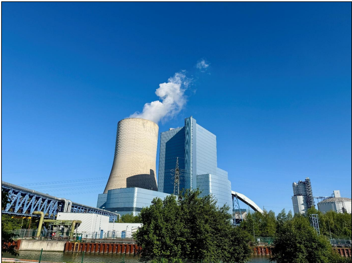
Abb. 4-1: Das Kraftwerk Datteln 4 im Jahr 2024.
