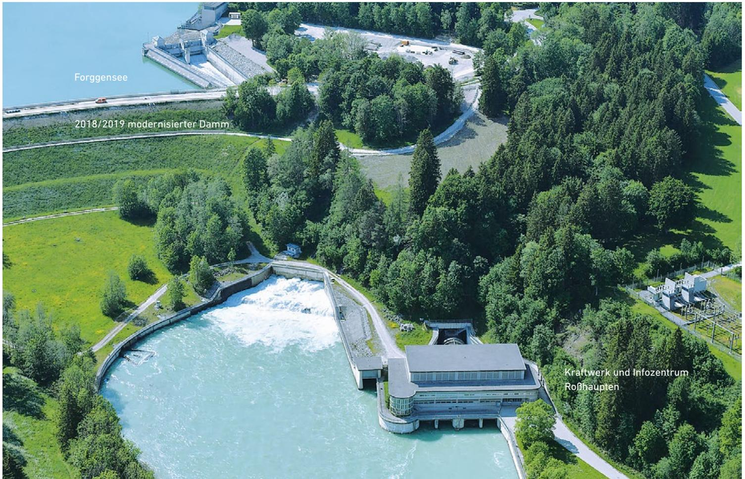
Die Hochwasserentlastungsanlage am Forggensee stellt eine zusätzliche Möglichkeit zur Absenkung dar, wenn große Zuflüsse erwartet werden.
